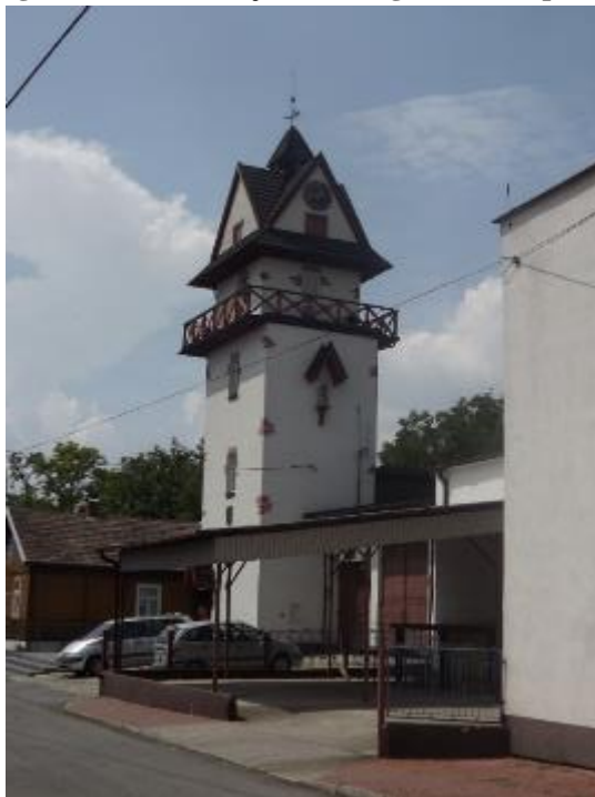
Fotografia 12 Wieża hejnalowo-zegarowa w Opatowcu
