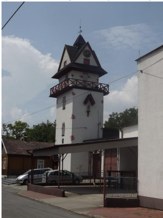
Fotografia 12 Wieża hejnalowo-zegarowa w Opatowcu
