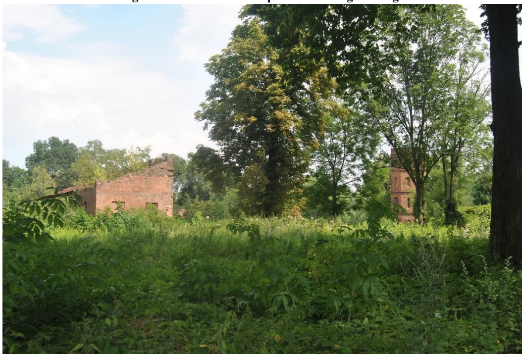
Fotografia 9 Pozostałości zespołu dworskiego w Rogowie
